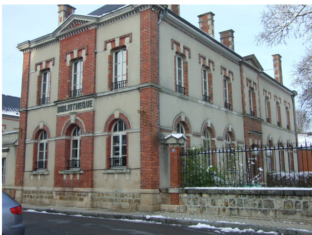
Vue extérieure de la bibliothèque
