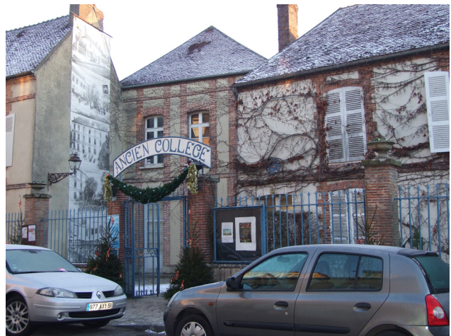
Vue extérieure de la bibliothèque
