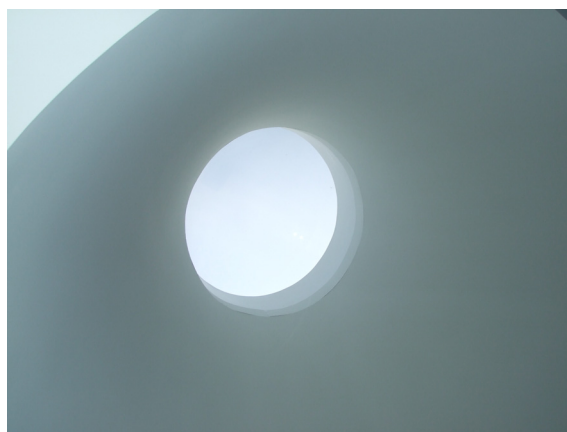
Puits de lumière
