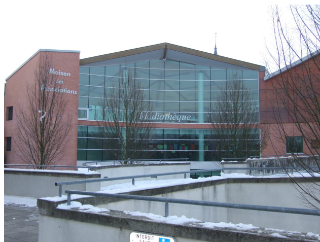
Vue extérieure de la médiathèque
